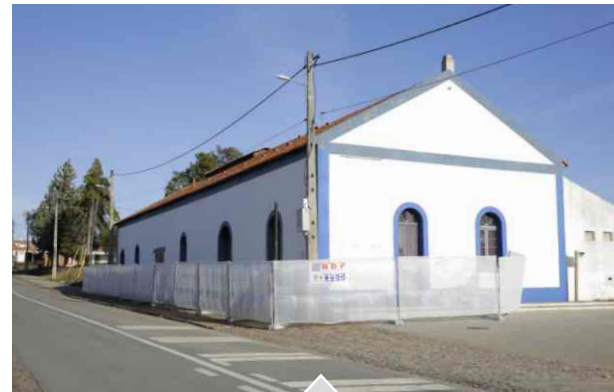
// Remodelação Cine-Teatro, Mina S. Domingos
