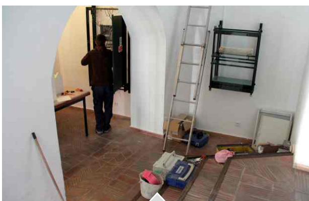
// Trabalhos de conservação - Museu Islâmico
