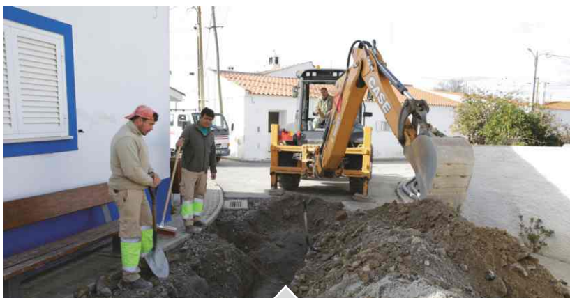
// Substituição da Rede de Águas, Penedos
