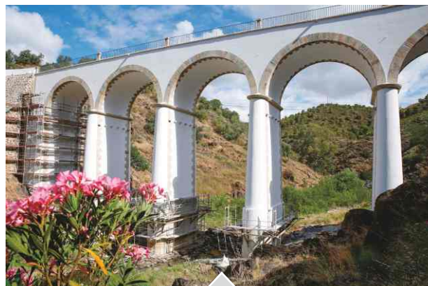
// Ponte sobre a Ribeira de Oeiras, Mértola
