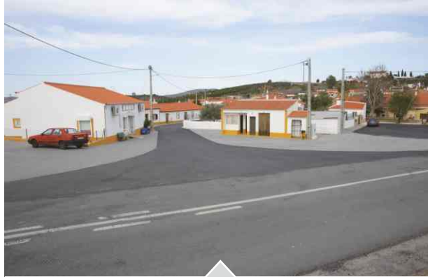
// Pavimentação e Arruamentos, S. João Caldeireiros
