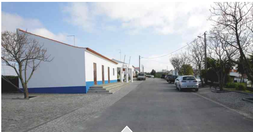
// Rede de Águas, Saneamento e Pavimentação, S. Miguel Pinheiro
