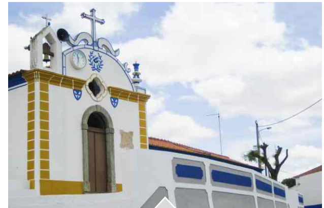
// Beneficiação da Igreja de Montes Santana*
