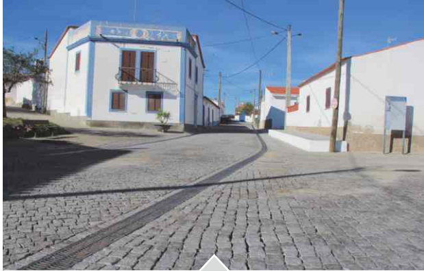
// Pavimentação e Arruamentos, Corte Gafo Cima
