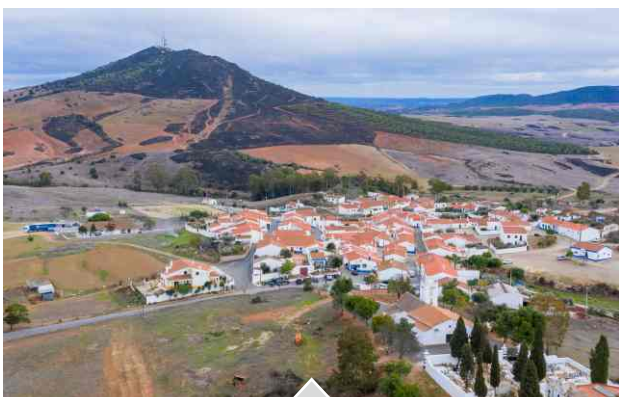
// Saneamento e Pavimentação, Alcária Ruiva
