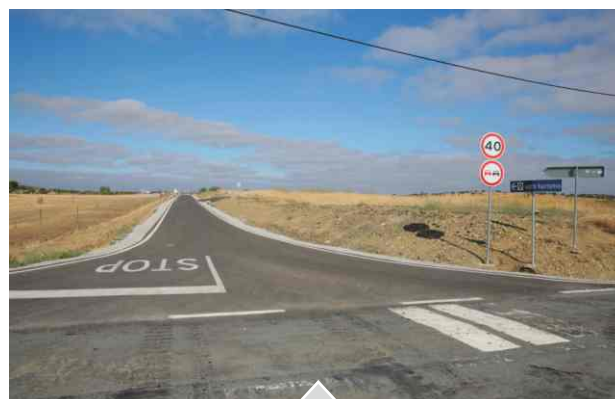
// Pavimentação de Caminho Moreanes - Guizo
