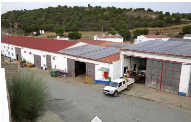
// Substituição de Coberturas em Amianto
