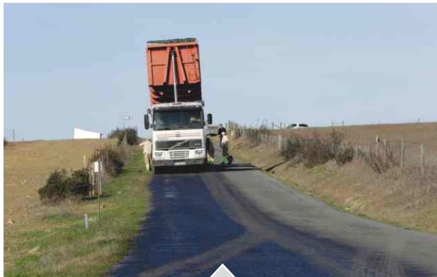
// Pavimentação Estrada Penilhos - S. João Caldeireiros
