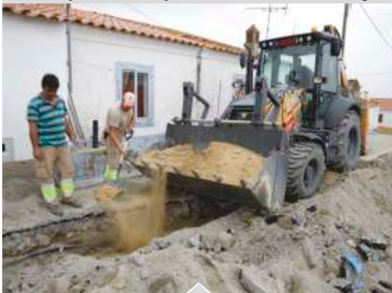
Substituição Rede Águas - Penedos
