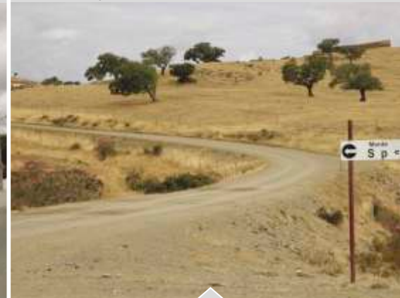
Reparação de Estrada - Sapos/Santana de Cambas
