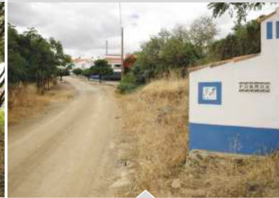
Reparação de Estrada - Formoa/Picoitos
