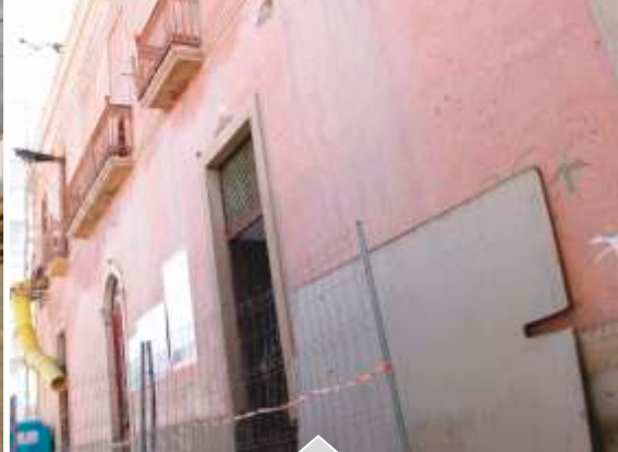
Reabilitação da Casa Cor de Rosa - Mértola
