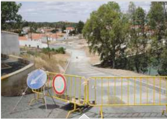
Construção de Passeios e Pavimentação - Mina S. Domingos
