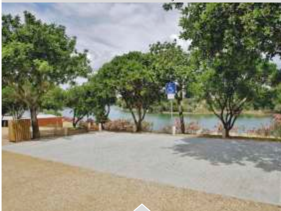
Construção de Passadiço - Praia Fluvial Mina S. Domingos
