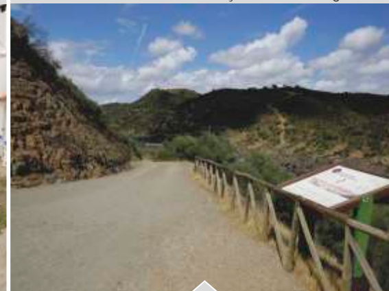
Reparação Estrada de Terra Batida - Pulo do Lobo
