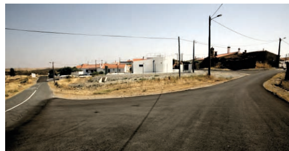
Saneamento e Pavimentação João Serra
