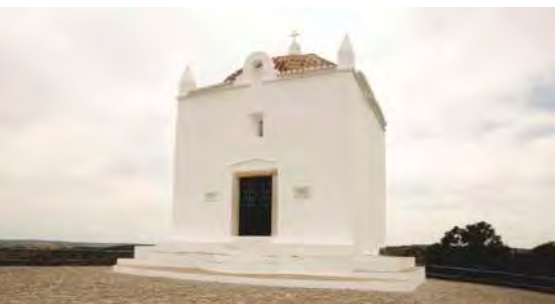
Reparações na Igreja N.ª Senhora das Neves
