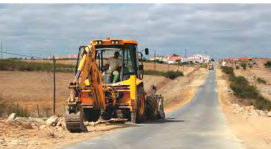
Pavimentação de Arruamentos e ramal de acesso em betuminoso em Tacões
