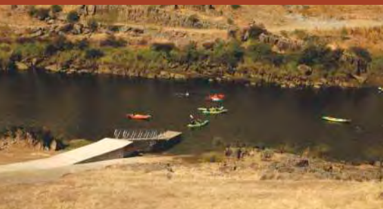
Construção de rampa de acesso à plataforma no Rio Guadiana
