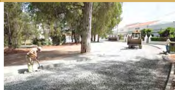
Pavimentação de acesso ao Hotel da Mina de São Domingos
