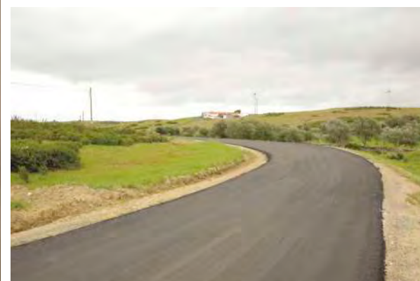
Repavimentação da Estrada Municipal EM 506
