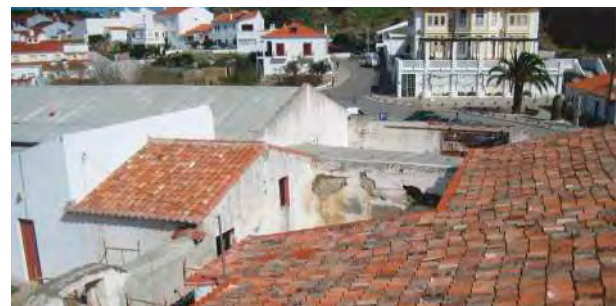
Reparação dos telhados dos Antigos Bombeiros
