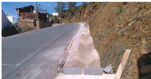
Beneficiação de drenagens pluviais no Pomarão
