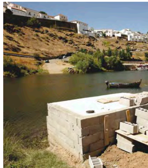
Instalação de Cais Flutuantes em Mértola
