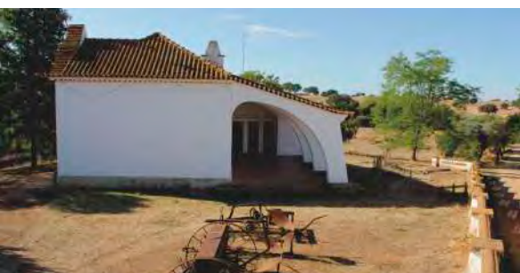
Reparações na Escola de Vale Formoso
