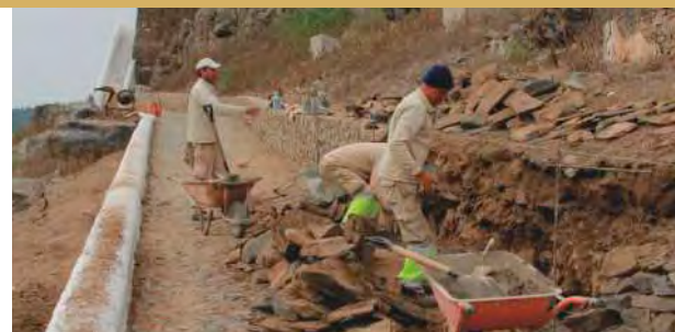
Recuperação dos muros de acesso à Torre do Relógio
