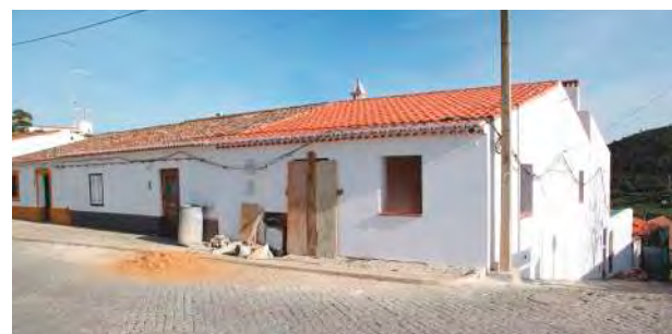
Remodelação da Casa Marciano e Mário Elias em Mértola
