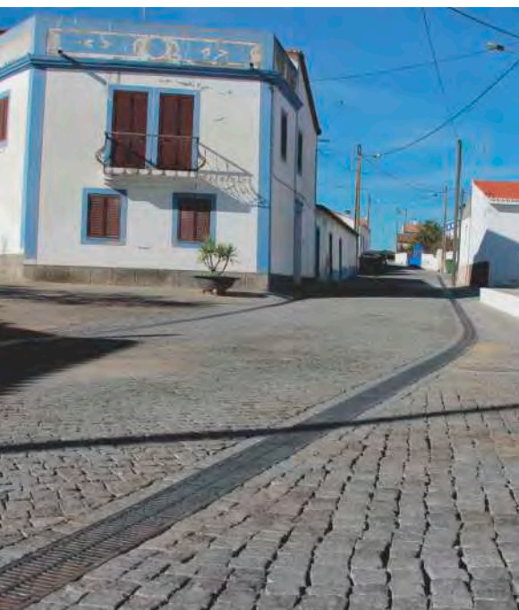
Saneamento e arruamentos em Corte Gafo de Cima
