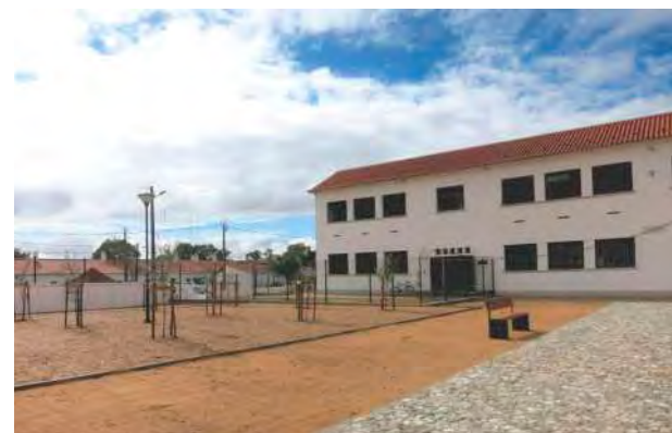
Centro Escolar na Mina S. Domingos
