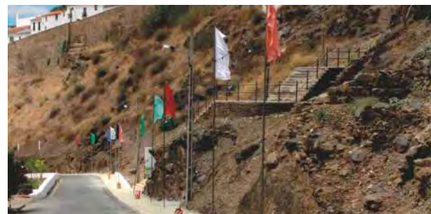
Construção de Passeio no acesso ao Cais do Guadiana em Mértola
