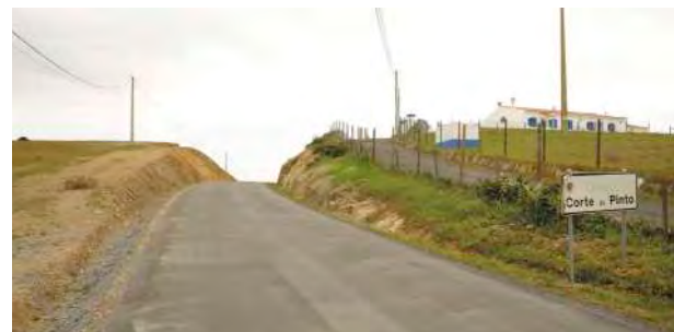
Remodelação da Entrada de Corte do Pinto
