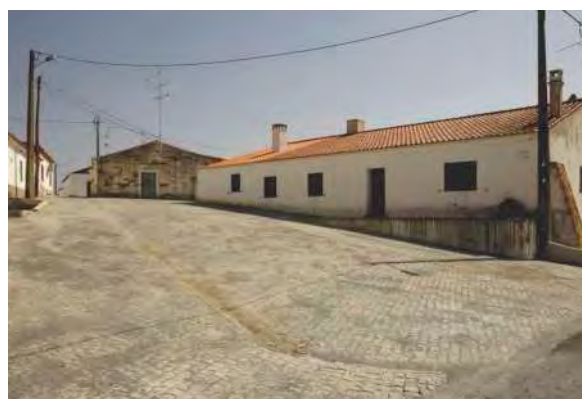
Saneamento e arruamentos em João Serra
