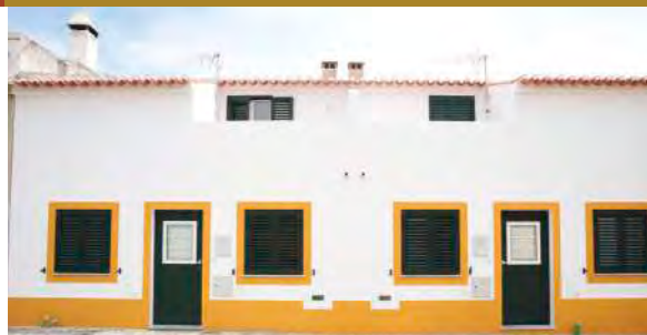
Reconstrução de Habitação em Além Rio
