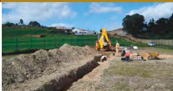
Melhoria na ETAR de Alcaria Ruiva
