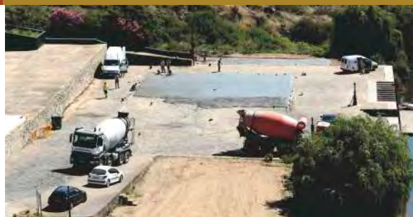
Obras no Cais do Guadiana
