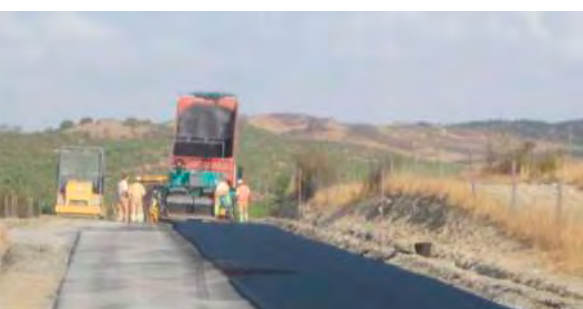
Repavimentação da Estrada Municipal EM 1171
