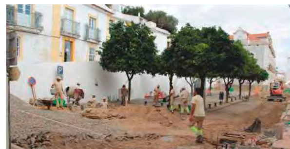
Melhoria de Pavimentos e substituição de redes de água e fibra ótica em Mértola
