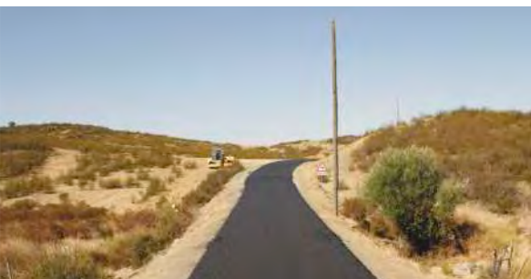
Repavimentação da estrada João Serra-Namorados
