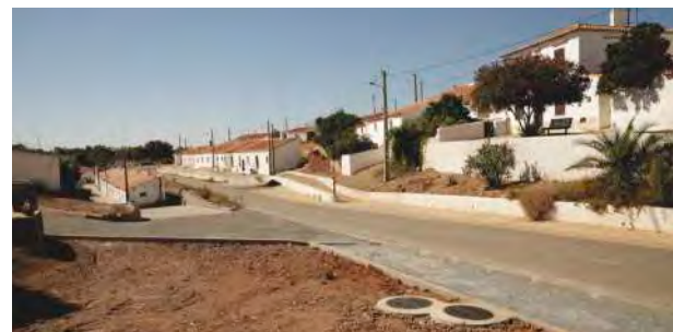
Coletores Pluviais na Rua S. Pedro Mina S. Domingos
