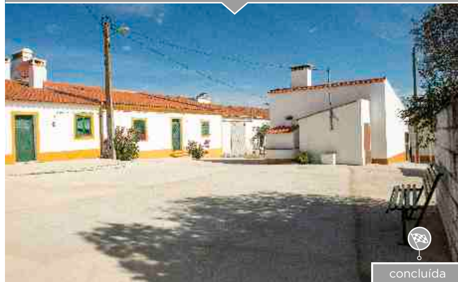
Pavimentação de arruamentos - Navarro
