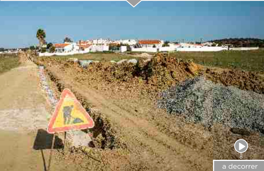
Rede saneamento básico e arruamentos Sapos (Santana)
