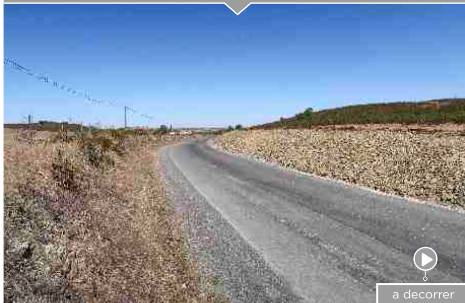
Corte de curvas e pavimentação de Estrada S. João Caldeireiros - Ponte Calçadinha
