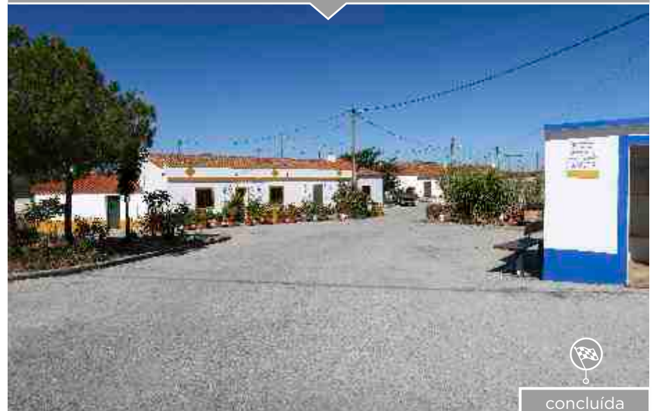
Pavimentação e Arruamentos - Moinhos de Vento Baixo
