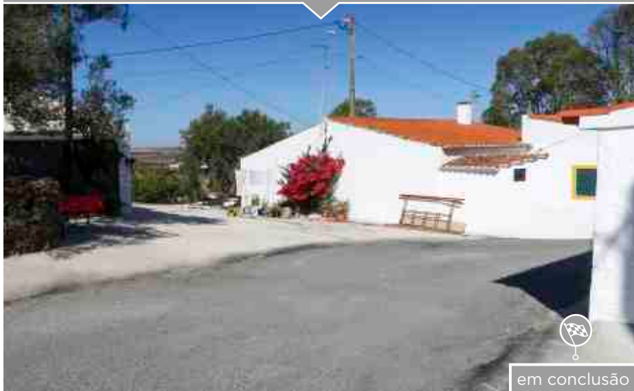
Pavimentação e Arruamentos - Moinhos de Vento Cima
