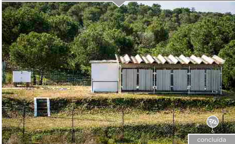
Manutenção de edifícios - ETAS
