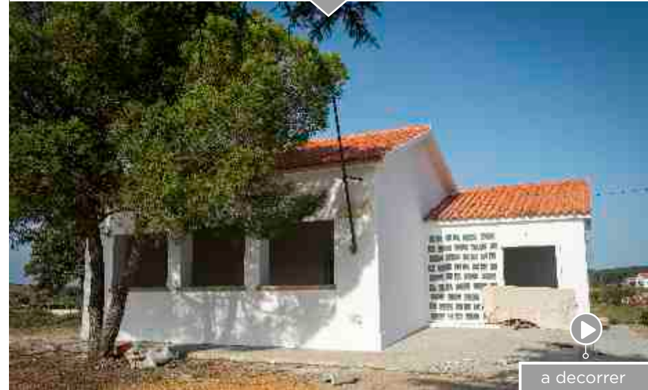
Construção do Centro de Ciências do Corvos
