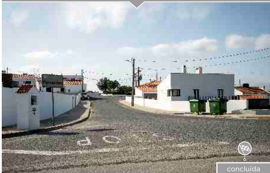
Construção de passeio na entrada dos Fernandes
