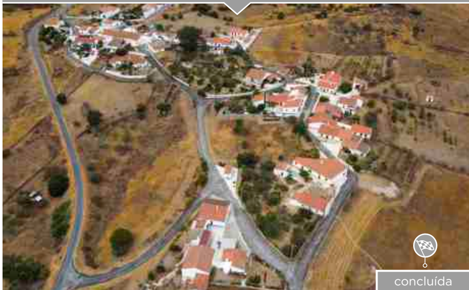
Pavimentação / Arruamentos Ronçães
