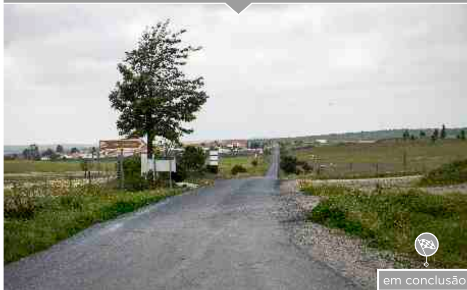
Pavimentação estrada Martinhanes - Penilhos
