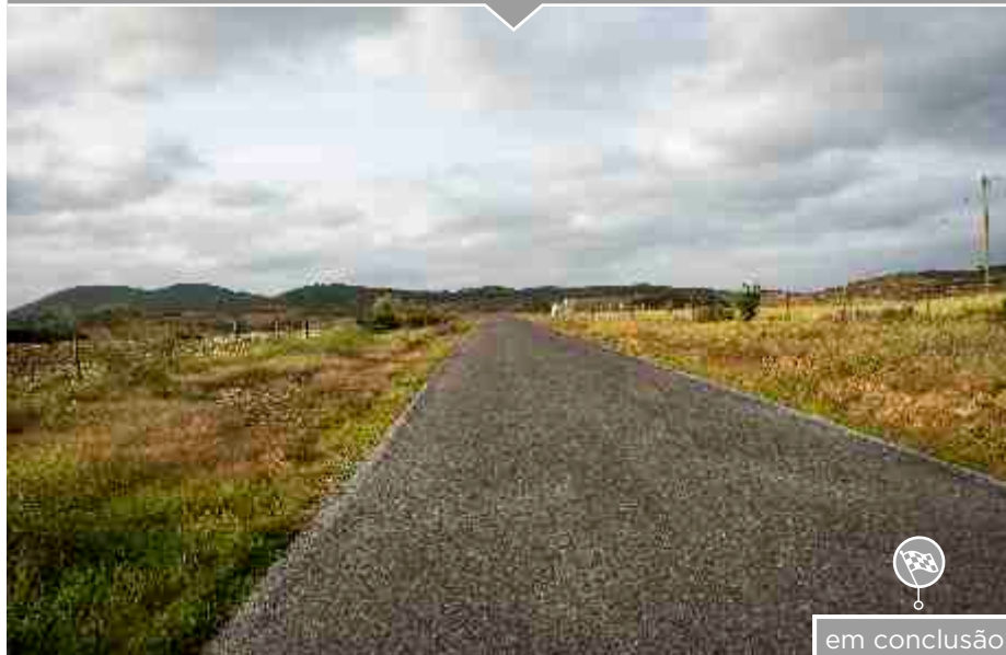
Pavimentação estrada Corte Gafo de Cima - Mértola
