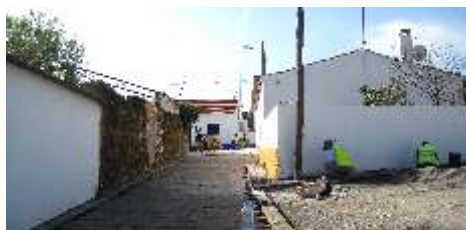
Pavimentação de arruamentos | Moreanes
