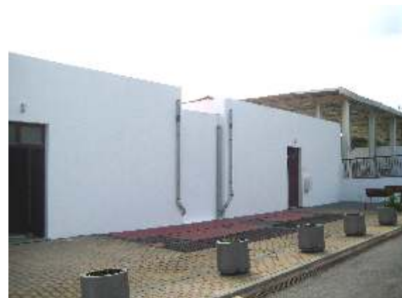
Renovação dos balneários do Campo de Futebol
