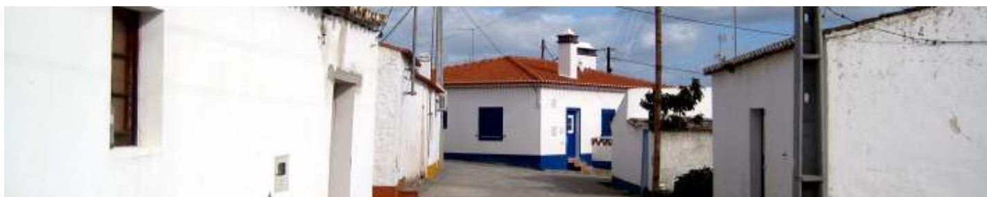
Pavimentação de arruamentos | Corte Gafo de Cima
