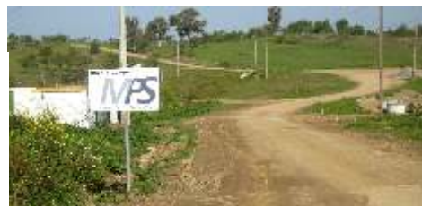
Pavimentação de caminho | Moreanes-Guizo
