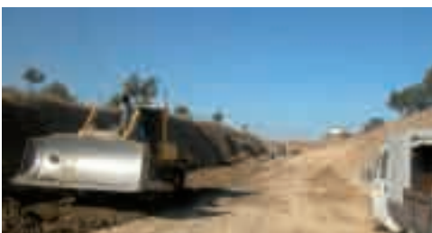
Pavimentação do CM 1096
