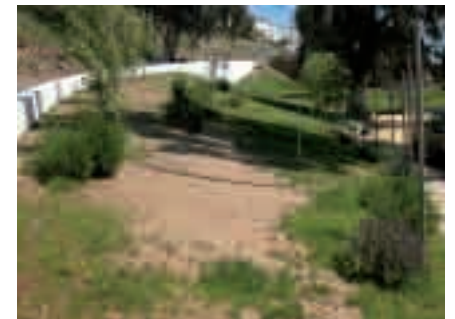
Hidroseteiras no cais do Guadiana
