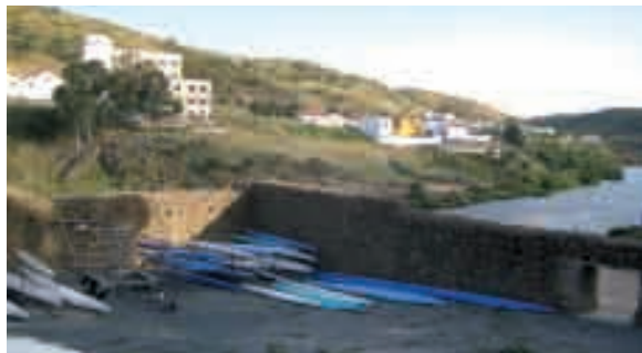
Limpeza e arranjo para hangar do Clube Náutico
