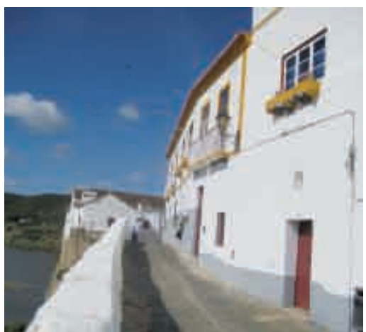
Conservação e pintura - Casa Fagulha
