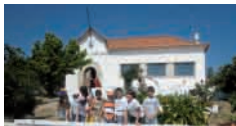
Remodelação do Parque Escolar EB1 de S. Miguel do Pinheiro
