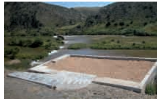
Construção Miradouro nas Azenhas
