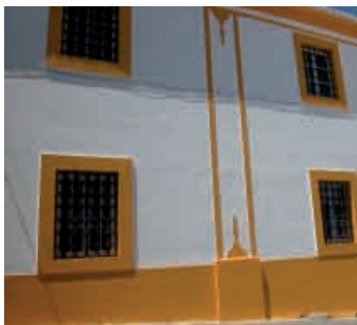
Conservação e pinturas – Biblioteca Municipal
