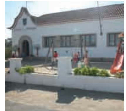
Remodelação do Parque Escolar EB1 de Algodor
