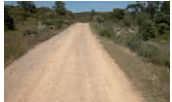
Reparação de Estradas de Terra Batida
