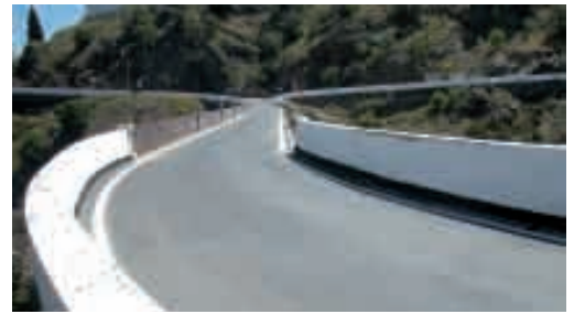
Pavimentação da Ponte sobre a ribeira de Oeiras, em Mértola
