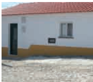
Ligação de ramais de água em S. João dos Caldeireiros
