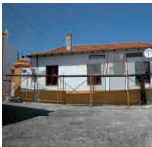
Conservação e pinturas – Mercado Municipal
