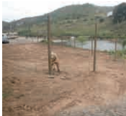
Vedação do Cais
