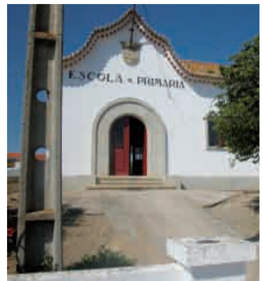
Remodelação do Parque Escolar EB1 de Penilhos
