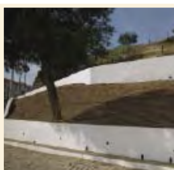
Instalação de sistemas de rega em Mértola
