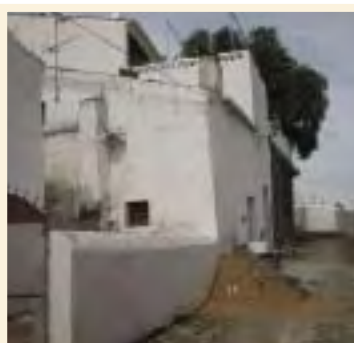
Recuperação de edifício Municipal – Mértola
