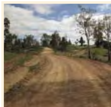
Arranjo estrada de terra batida – Mina de S. Domingos
