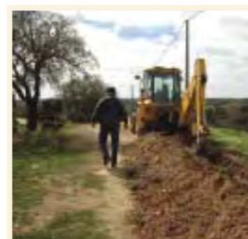
Valas de abastecimento de água em Vale Pereiro de Serra e em Corte Gafo de Baixo
