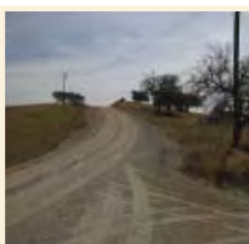
Várias reparações em estradas de terra batida
