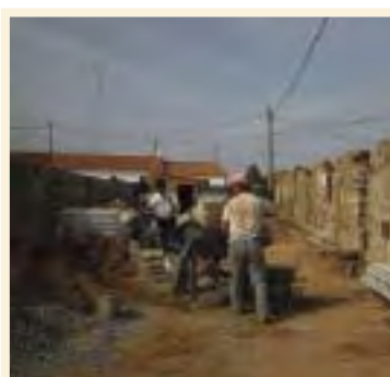
Recuperação de Casas na Mina
