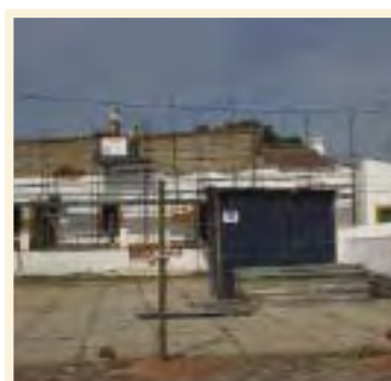
Recuperação do Centro Republicano – Mina de S. Domingos
