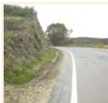
Limpeza das valetas
