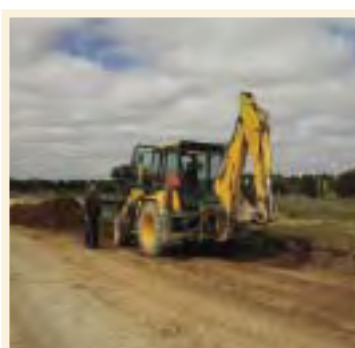
Pavimentação da estrada Corte Pequena (Além-Rio)
