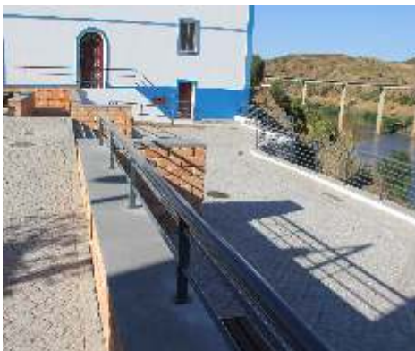
Muro de suporte - acesso à frente ribeirinha
