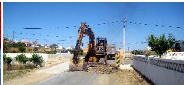
Pavimentação do ramal para os Fernandes
