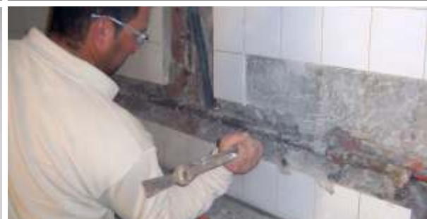
Reparação de casa para habitação social
