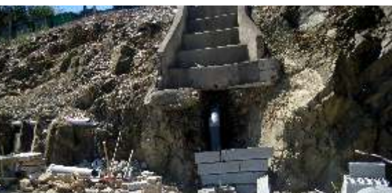
Acesso ao loteamento do Ze2
