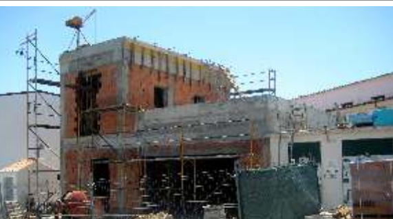
Construção da sede do Moto Clube
