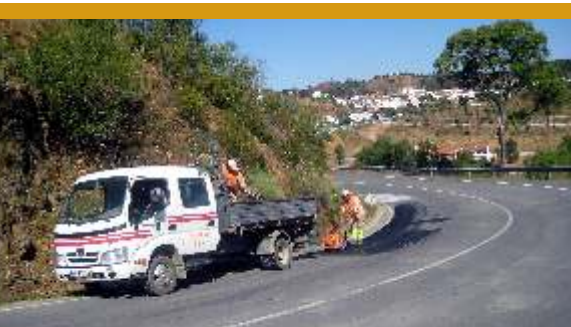
Reparação de estradas
