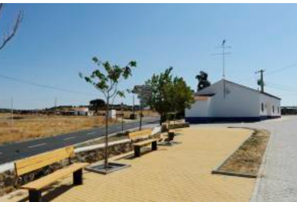
Pavimentação de arruamentos em Corvos
