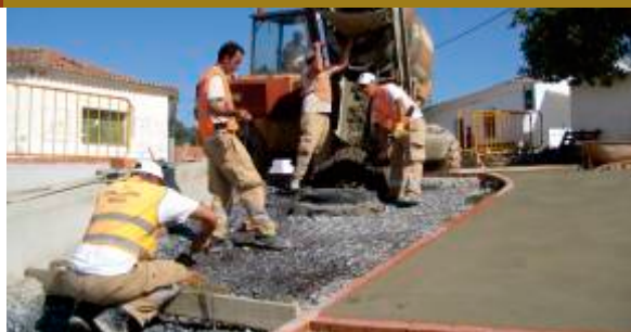
Pavimentação na Mina de S. Domingos
