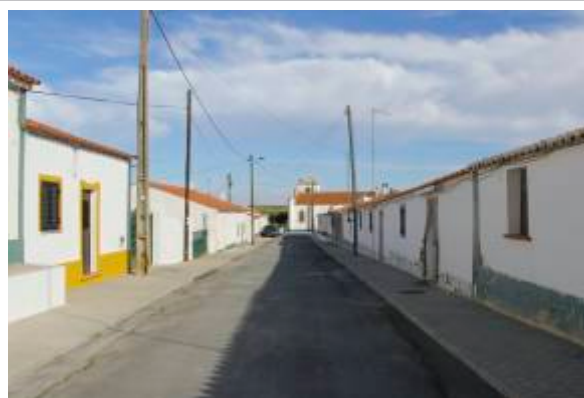
Arruamentos em Vale de Açor de Cima
