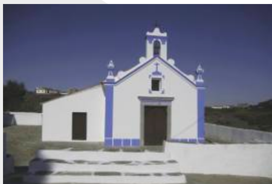
Obra de Recuperação da Ermida de Montes Santana
