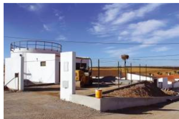
ETAR de Vale de Açor de Cima
