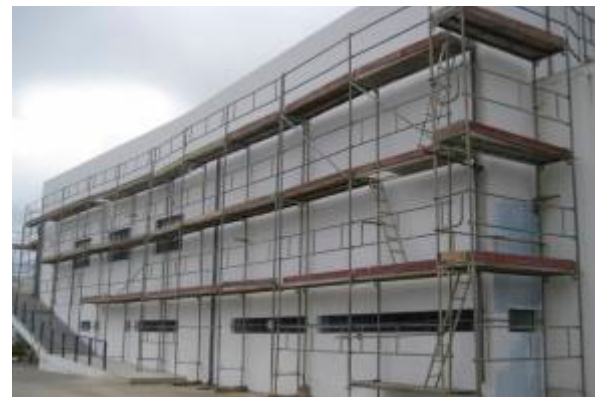
Remodelação da Cobertura do Pavilhão Municipal
