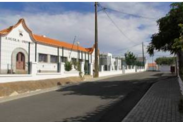
Saneamento e Repavimentação em Algodor
