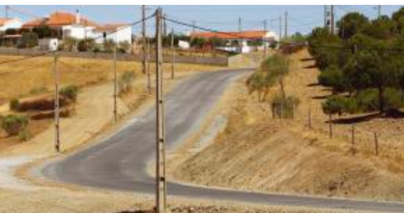
Reparação da estrada de acesso a Fernandes
