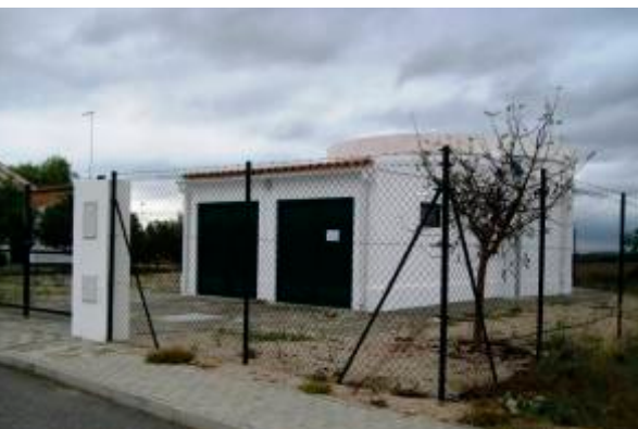
Saneamento e Pavimentação em S. Bartolomeu de Via Glória
