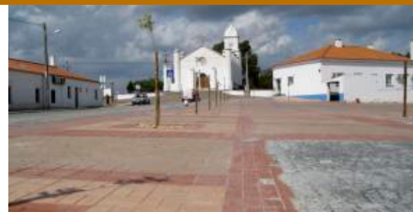
Pavimentação na Mina de S. Domingos
