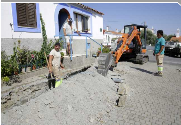
Substituição da Rede de Águas - Penedos
