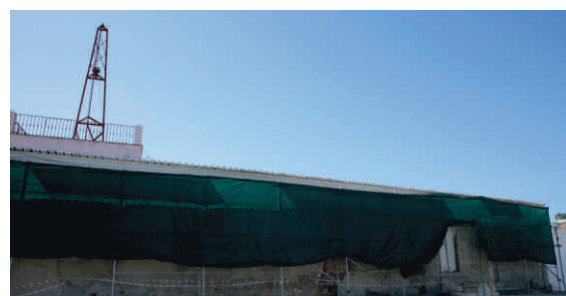
Recuperação do edifício dos Bombeiros Velhos Mértola
