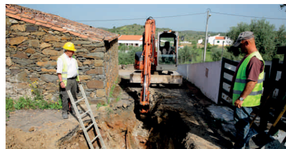
Saneamento e Pavimentação em Alcaria Longa
