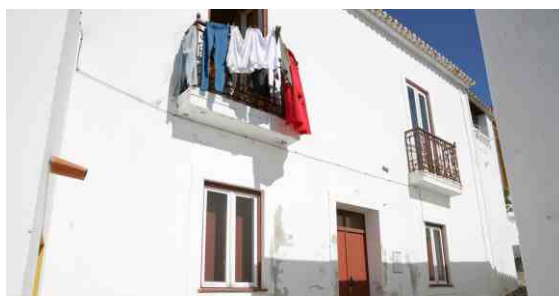
Recuperação da Casa Matilde - Mértola
