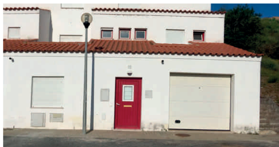
Reparação rotura e remodelação lote Encosta Noroeste Mértola
