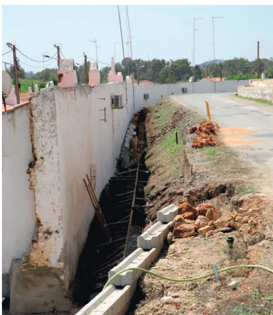
Construção de muro de suporte - Mina de S. Domingos
