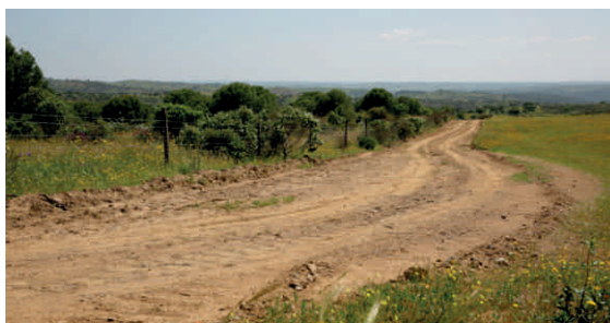
Reparação de estrada - Alves - Rio Guadiana
