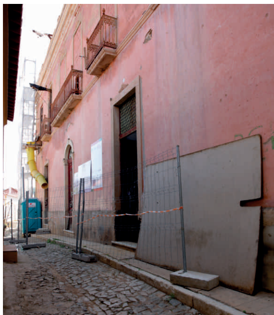
Reabilitação da Casa Cor de Rosa em Mértola
