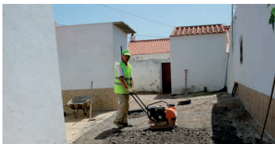
Saneamento e Pavimentação em Montes Altos
