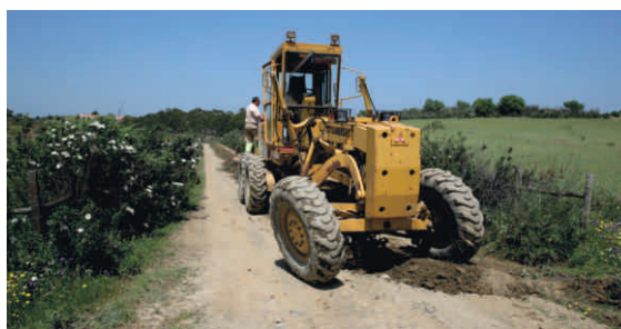
Reparação da estrada de terra batida Monte Velho - Espargosa
