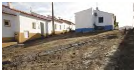
Saneamento e Pavimentação João Serra
