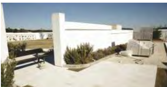
Reparações no Cemitério da N.ª Sr.ª das Neves Mértola
