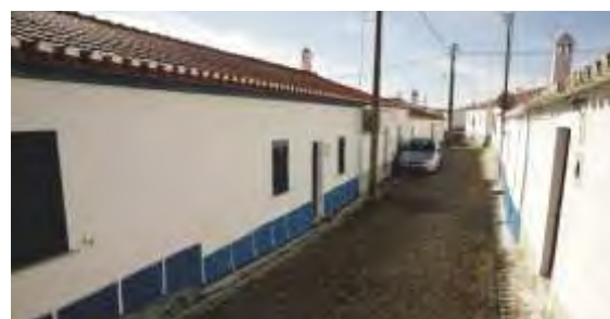
Drenagem de Águas Pluviais Bens
