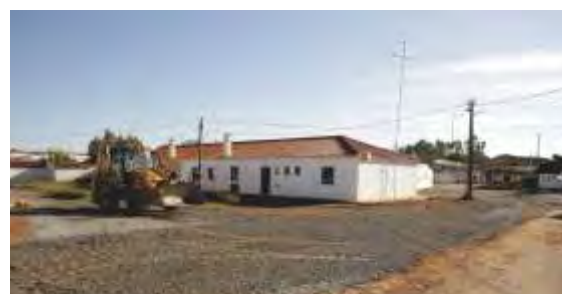
Arranjos na Rua da Indústria Mina de São Domingos
