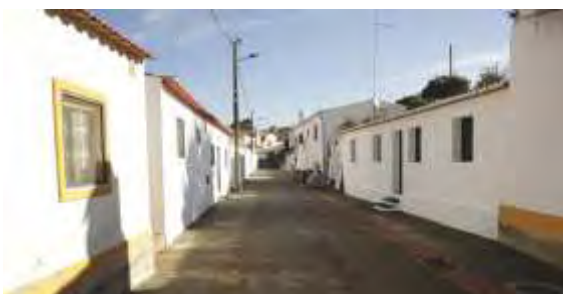
Pavimentação Rua de São Pedro Mina de São Domingos
