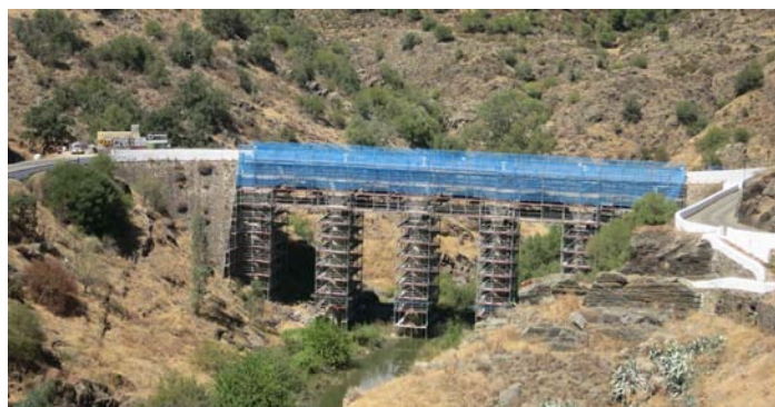
Reabilitação e Reforço de Ponte | Rio Oeiras | Mértola
