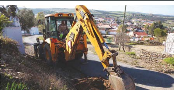
Recuperação de Arruamentos S. João Caldeireiros
