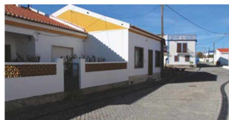
Drenos I Corte Gafo de Cima
