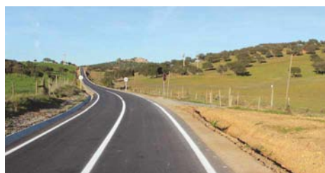
Pavimentação de Caminho Moreanes-Guizo
