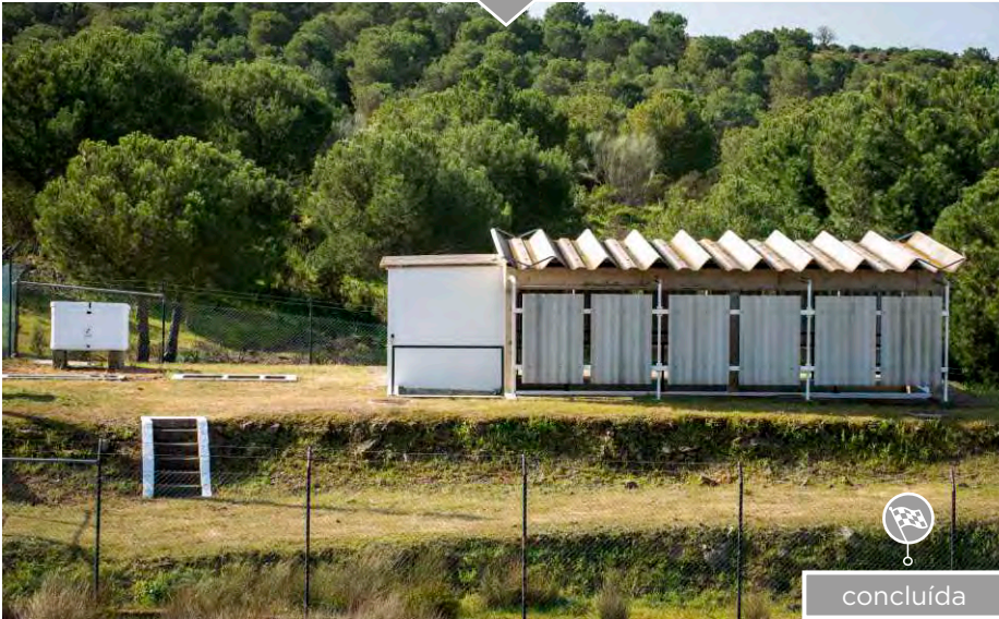
Manutenção de edifícios - ETAS
