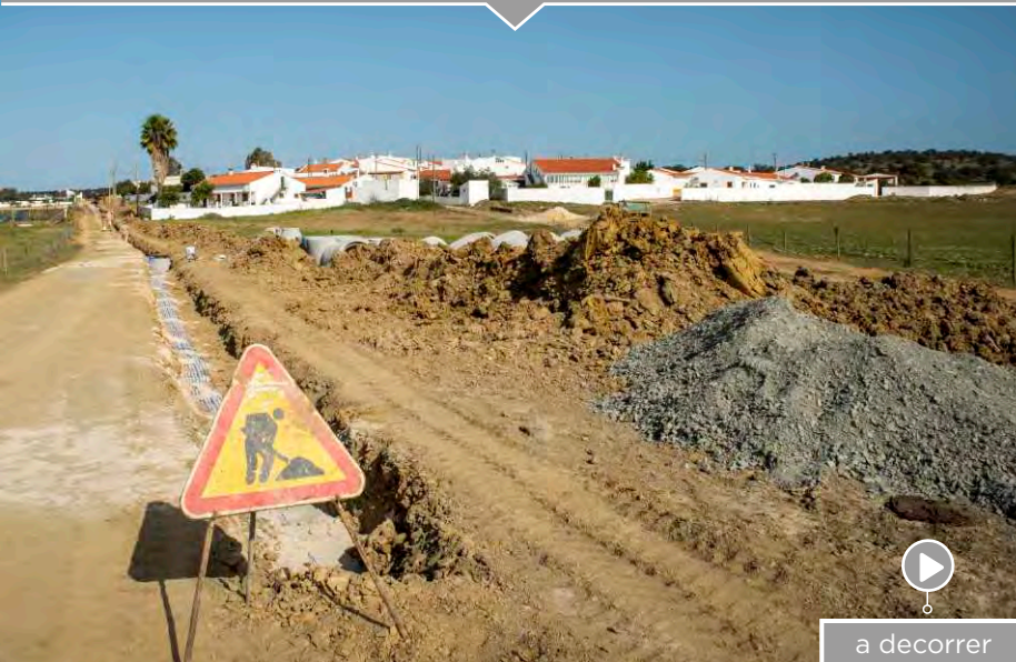
Rede saneamento básico e arruamentos Sapos (Santana)
