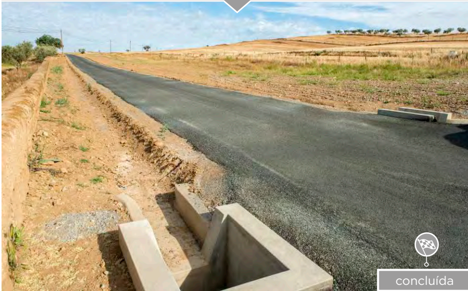
Estrada e drenagem na circular - Vale de Açor de Baixo
