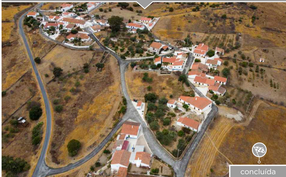
Pavimentação / Arruamentos Ronções
