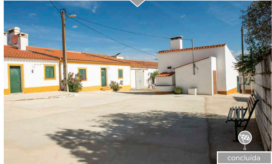
Pavimentação de arruamentos - Navarro
