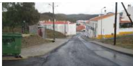
Tratamento Pavimentos Betuminosos | Mértola
