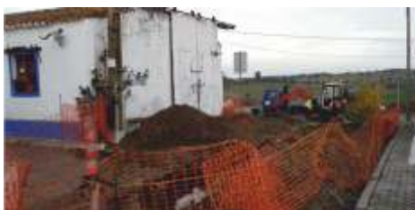
Pavimentação de arruamentos | Moreanes
