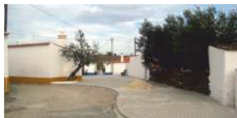
Pavimentação de Arruamentos | Corte Gafo de Cima
