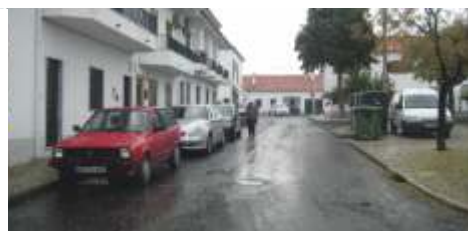
Tratamento Pavimentos Betuminosos | Mértola
