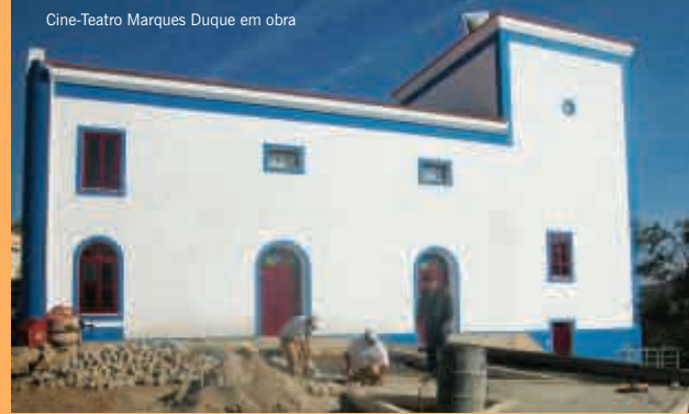
Cine-Teatro Marques Duque em obra
