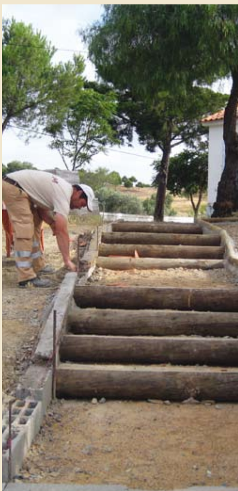
Reparação da Escola dos Fernandes
