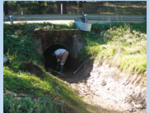
Limpeza de linhas de água na Mina de S. Domingos
