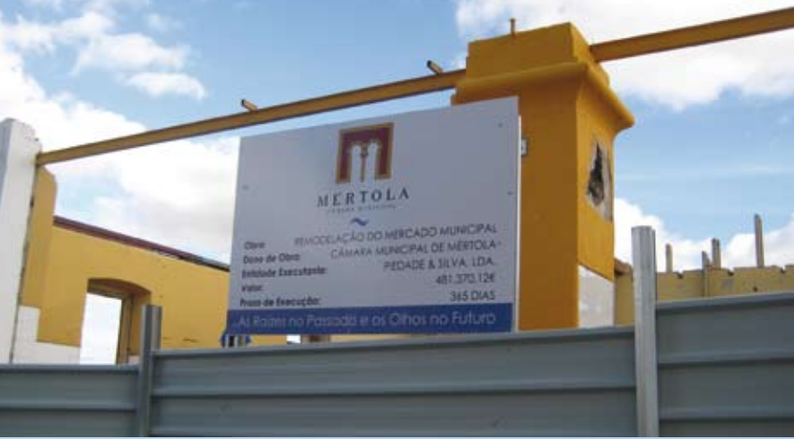
Obra do Mercado Municipal
