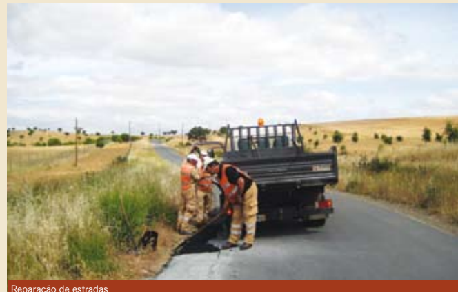
Reparação de estradas
