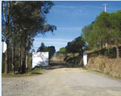
Reparação da estrada de terra batida de acesso à lixeira
