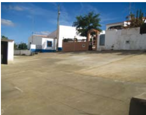
Reparação de arruamentos nos Lombardos
