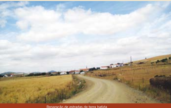
Reparação de estradas de terra batida
