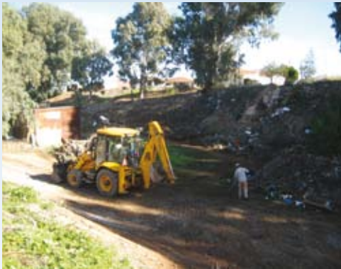
Limpeza de linhas de água na Mina de S. Domingos
