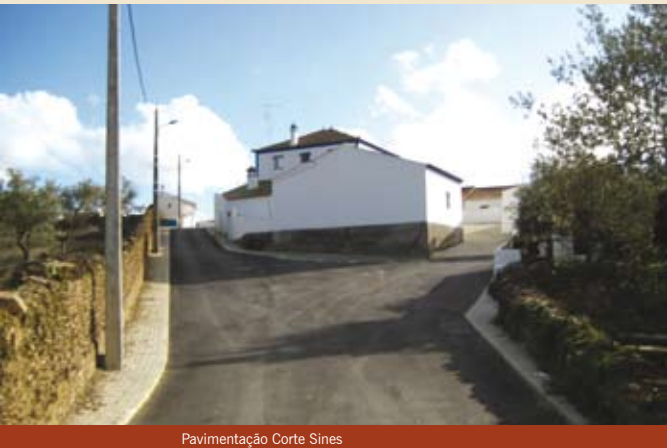
Pavimentação Corte Sines
