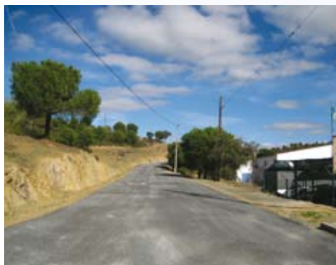
Reparação da estrada de terra batida de acesso à ETA
