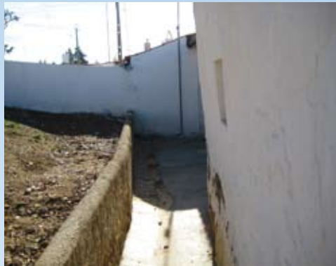
Reparação de regatas de águas pluviais na Mina de S. Domingos
