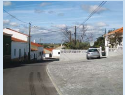
Construção de esgotos e arruamentos em Penilhos
