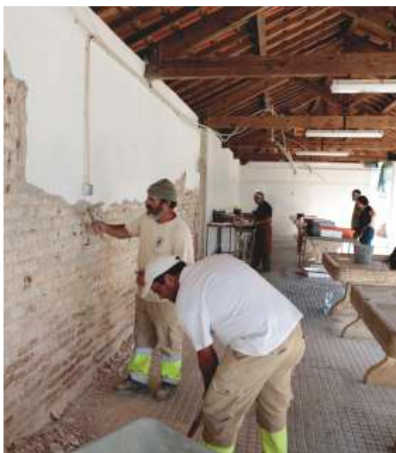
Obras no Mercado Mina S. Domingos
