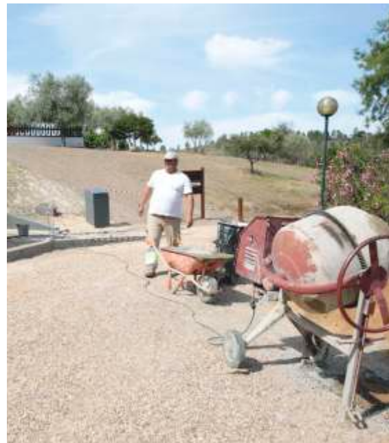
Construção de rampa na Praia Fluvial Mina S. Domingos
