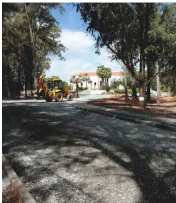
Pavimentação do acesso ao Hotel Mina S. Domingos
