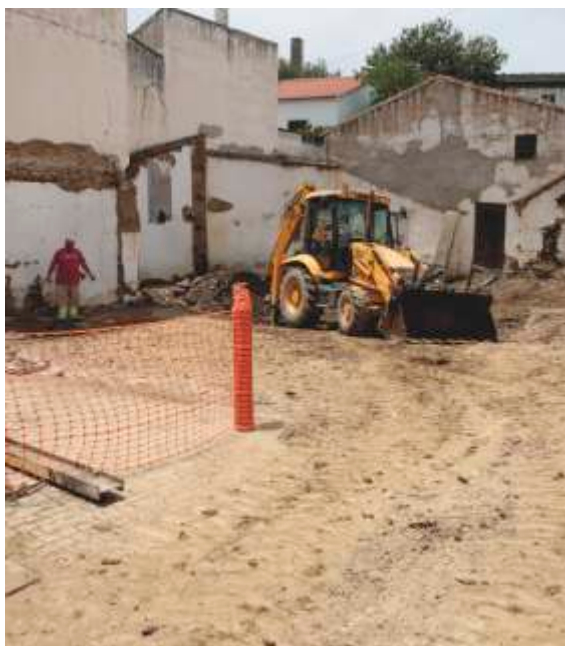
Demolição de ruínas Mértola
