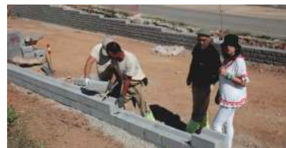
Obras na rua de S. Pedro Mina S. Domingos
