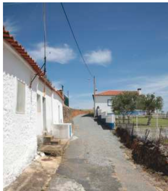
Preparação de arruamentos Corte do Pinto
