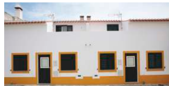
Reconstrução de habitação em Além Rio Mértola
