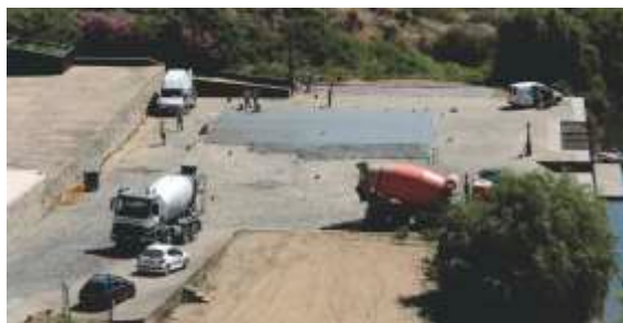
Obras no Cais Mértola
