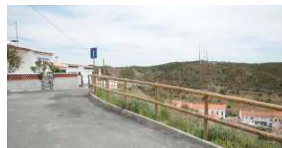
Corrimão de proteção em Cerro do Benfica Mértola
