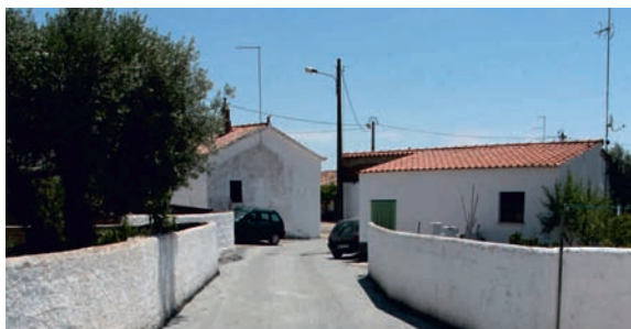
Repavimentação em Betuminoso | Tacões
