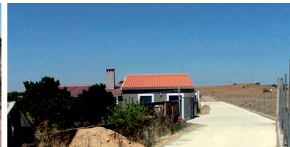
Pavimentação e Arruamentos Namorados
