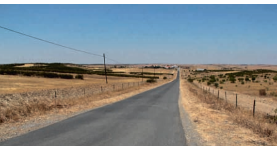
Beneficiação de pavimentação da Estrada Penilhos-Figueirinha
