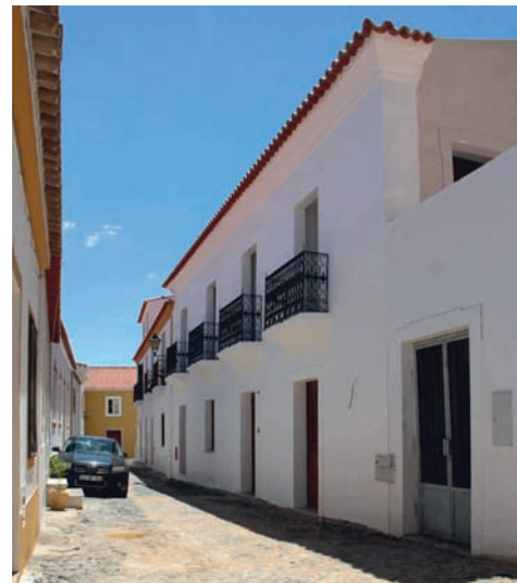
Remodelação Casa Branca | Mértola
