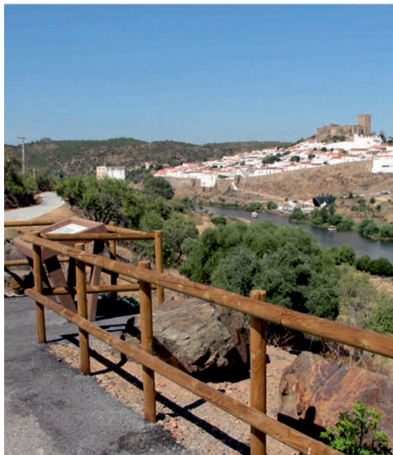
Estruturas de Proteção | Mértola
