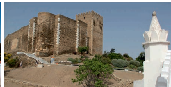
Arranjos Exteriores Castelo | Mértola
