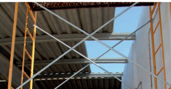
Substituição de Telhado da Oficina Estaleiro Municipal
