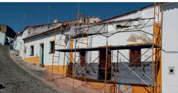
Remodelação da Cobertura de Edifício Municipal | Mértola
