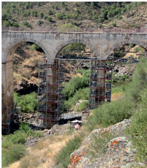
Reabilitação e Reforço | Ponte Ribeira Oeiras
