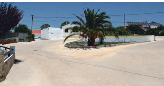
Pavimentação e Arruamentos em betonilha | S. João Caldeireiros
