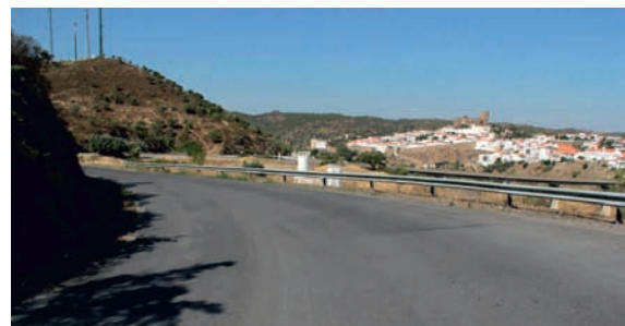
Repavimentação entre Ponte do Guadiana e Fernandes
