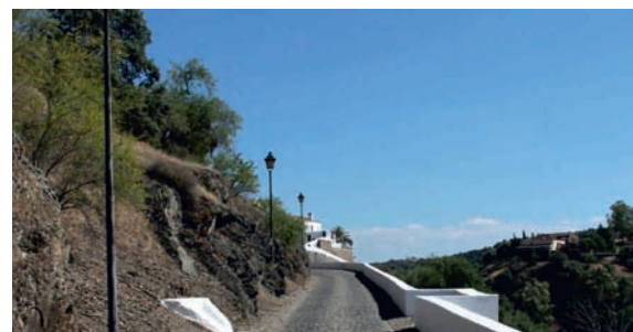
Pintura de Muros na Vila | Mértola
