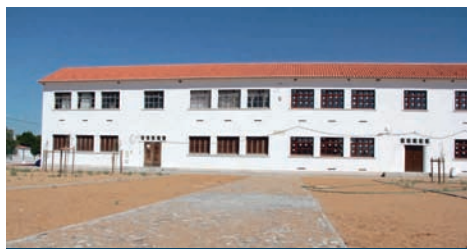
Remodelação Parque Escolar | Mina S. Domingos
